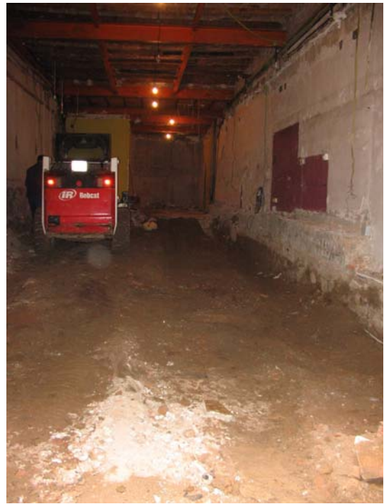
FOTO 2 Treballs d'excavació mecànica
