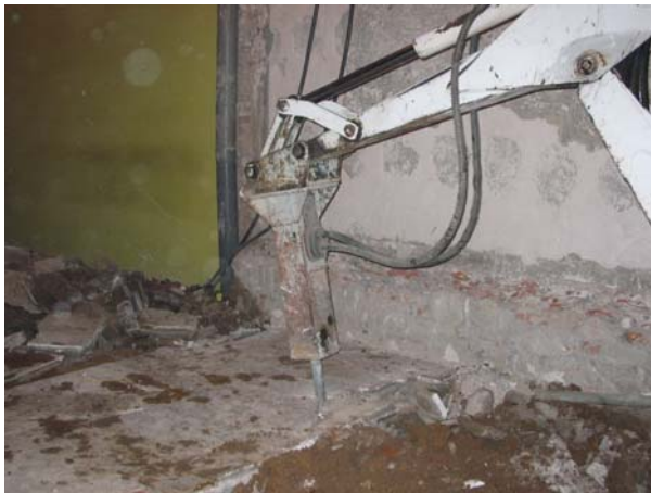
FOTO 3 Treballs d'excavació mecànica dels paviments contemporanis
