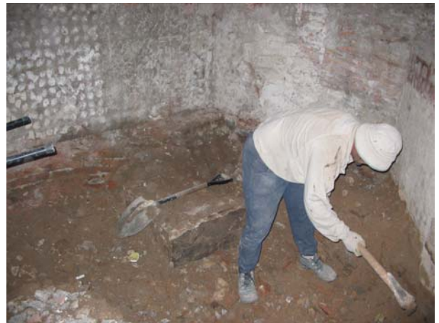
FOTO 4 Treballs d'excavació manual
